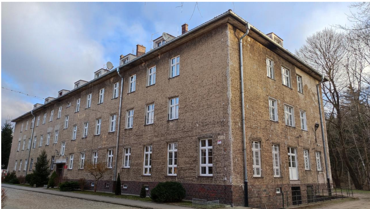
Fot. nr 1 – Elewacja frontowa i boczna.
